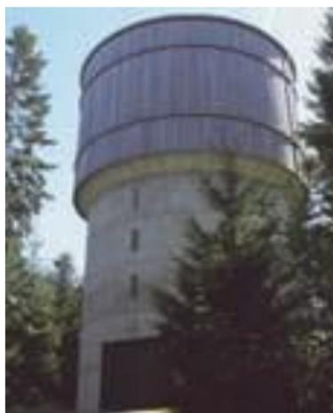
Der alte Hochbehälter auf der „Adlerhöhe“ stammte aus dem Jahre 1950 und wurde den gestiegenen Anforderungen nicht mehr gerecht. Die Wassergenossenschaft hat sich daher für den Bau eines neuen Hochbehälters in Form eines Wasserturmes entschieden. Er macht die Trink- und Löschwasserversorgung mit ausreichendem Druck im gesamten Versorgungsgebiet der Genossenschaft möglich.
